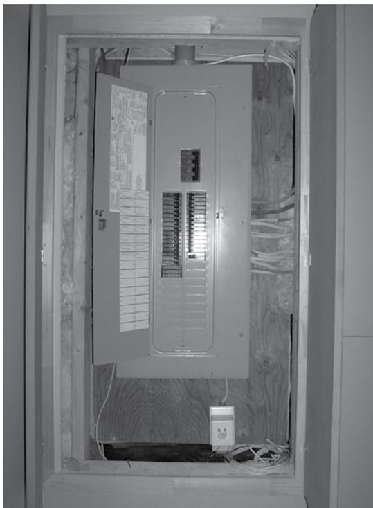
Si un appareil électrique ne fonctionne pas ou une prise de courant est défectueuse, vérifiez dans le panneau de dérivation l'état du disjoncteur. La plupart du temps, vous pourrez réenclencher le disjoncteur. S'il se déclenche de nouveau, parlez-en à l'entrepreneur.
