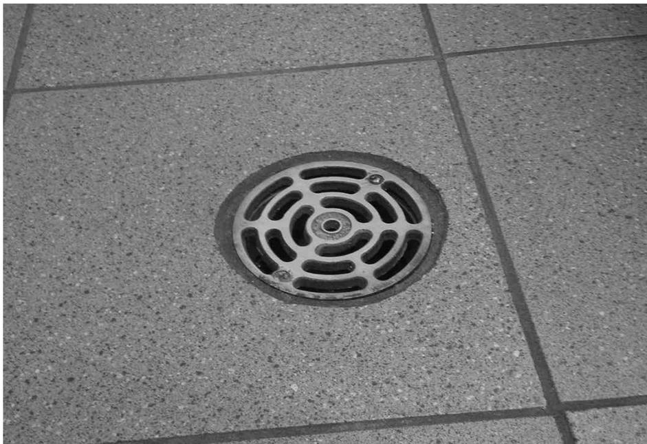
**Le réseau de drainage du bâtiment nécessite un entretien comme tout autre élément. Que ce soit les drains de plancher, les drains de toiture ou encore les regards de nettoyage, il est important de porter une attention particulière à leur entretien afin de préserver leur fonctionnalité maximale et de prolonger leur durée de vie.**
